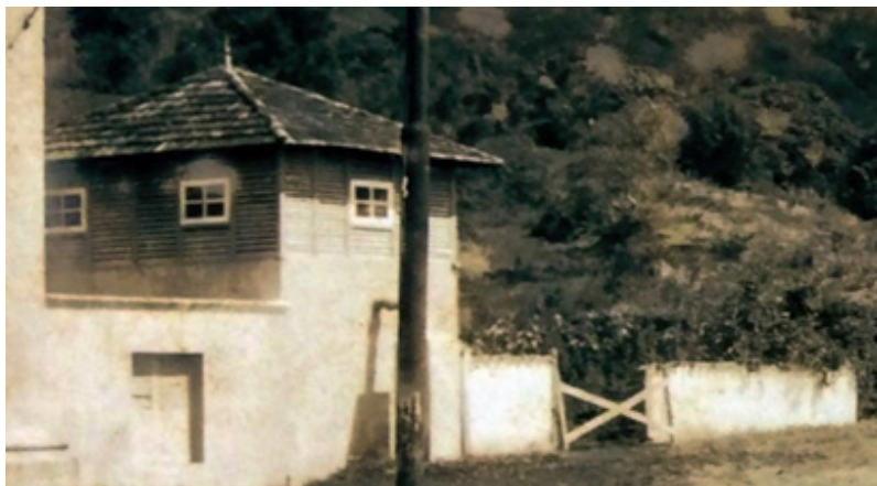
Figura 13 – Depósito de água na Praça Cristóvão Corrêa e Castro.
